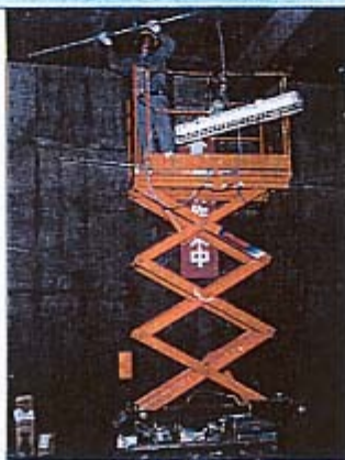
▲配管等の取り付け
